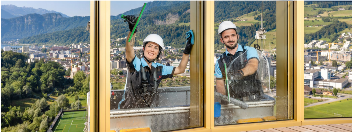
Unsere Mitarbeitenden bei der Fassadenreinigung der Hochzwei-Wohnhochhäuser
