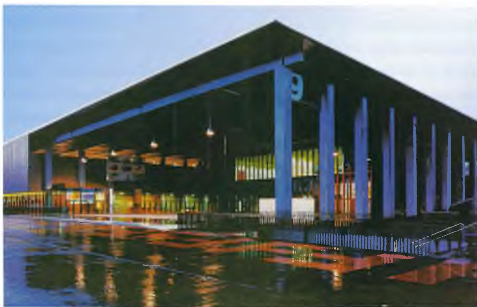
Die neue Halle 9 umfasst auf drei Ebenen rund 14'000 m 2 Nettofläche, was Investitionen von rund 40 Mio. Fr. bedingte
