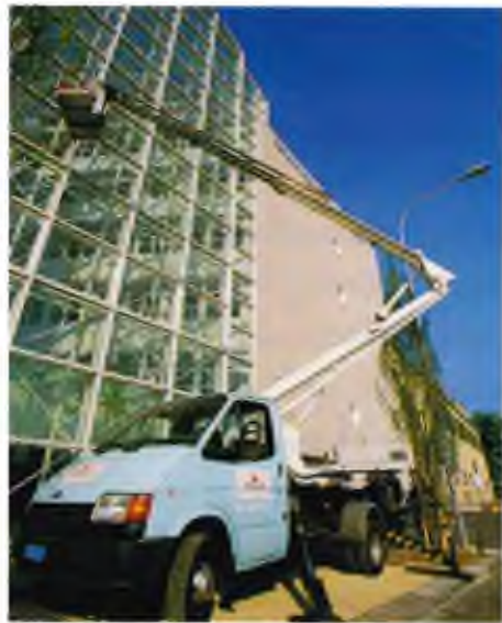
Der Sky-Lift mit 25 Metern Arbeitshöhe.
