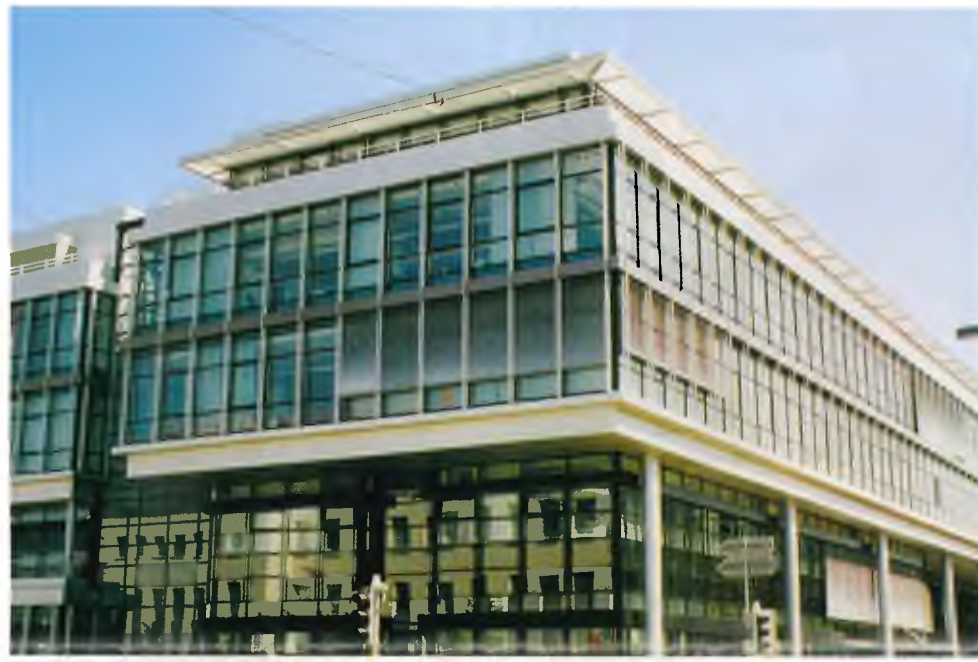
So präsentiert sich das moderne Bankgebäude von aussen.
