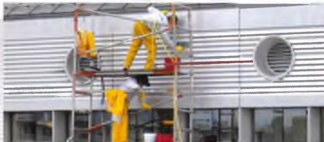
sivste Verschmutzungen in den Erkern mit ihrem verdeckten – und notabene nicht mehr funktionierenden – Entwässerungssystem zu beseitigen. Dazu mussten die sechs Erkerbereiche eingerüstet werden. Ebenfalls komplett gereinigt werden musste die ganze Aluminium-Fassade, inklusive aller Fenster und Lamellenstoren. Es zeigte sich schnell einmal, dass dafür sehr viel Handarbeit nötig war.
