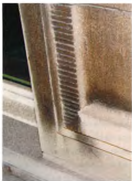
Fassadenteil vor der kombinierten Reinigung.
