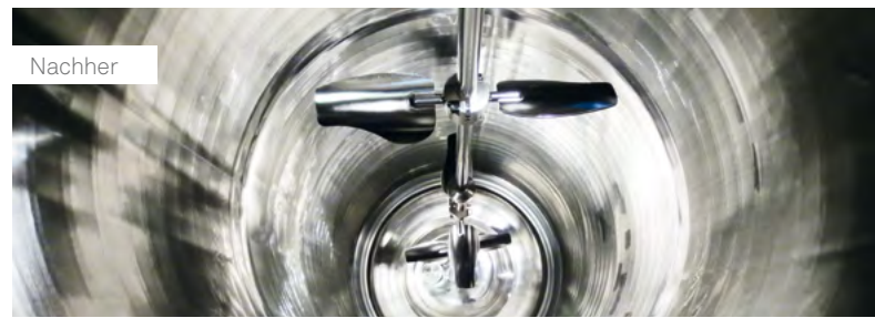
Reaktionsbehälter nach dem Derouging
