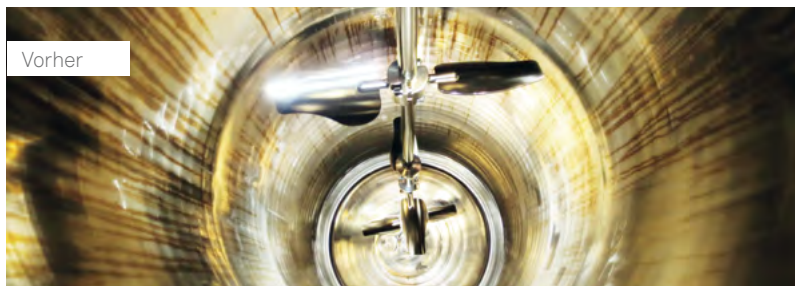
Rouging an einem 4 m³ Reaktionsbehälter
