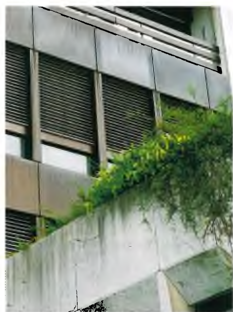
Gut sichtbare Verschmutzungen an Aluminium und Stein.
